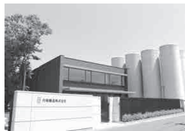
加茂郡八百津町 本社工場
